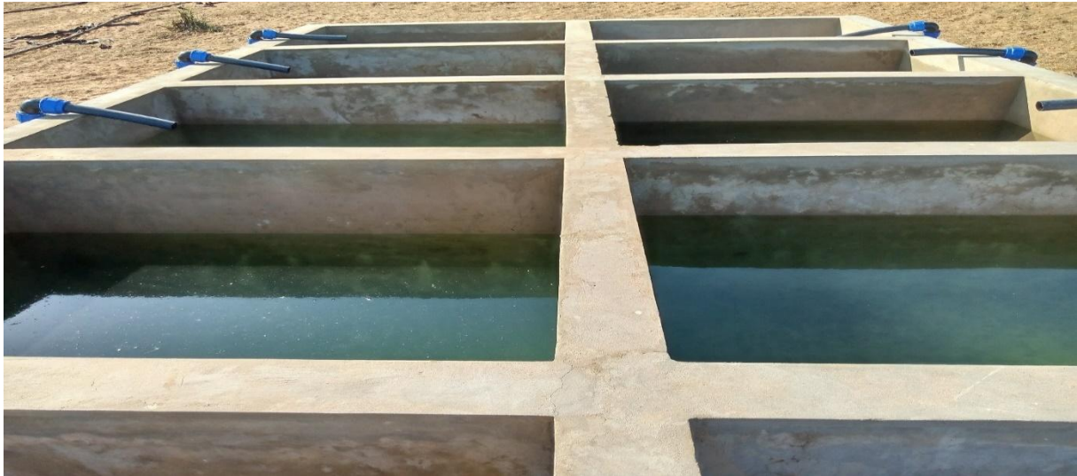
Photo 2 : Structure d'élevage en bassins (SANE, 2023)
