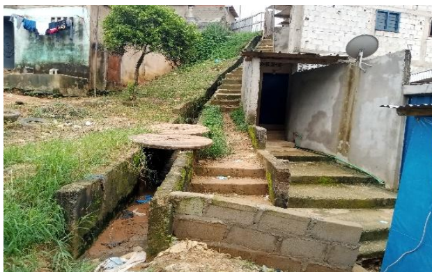
Photo 3 : Infrastructure d'assainissement informelle mise en place par les populations pour limiter les effets du ruissellement en zone de vallée au Pays-Bas extension, crédit photo : K. B. Yao, 2024.
