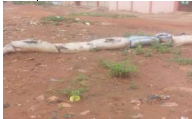
Planche 2: Pose de sacs et pneus
