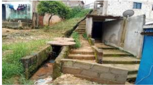
Photo 3 : Infrastructure d'assainissement informelle mise en place par les populations pour limiter les effets du ruissellement en zone de vallée au Pays-Bas extension, credit photo : K. B. Yao, 2024.
