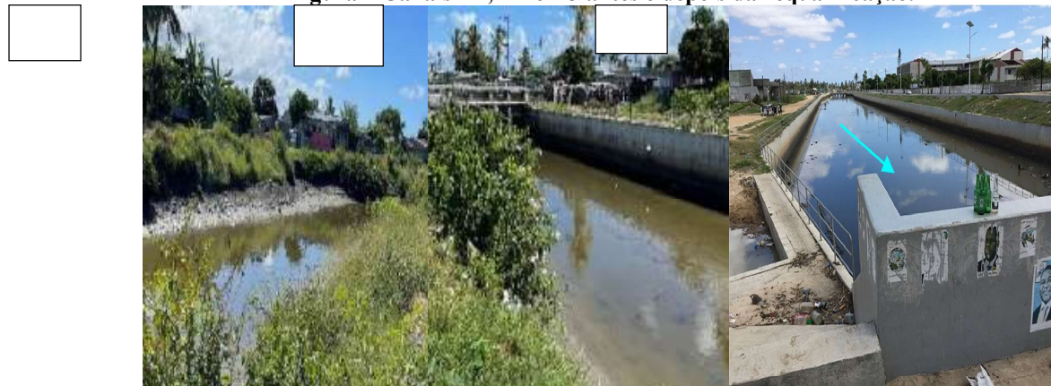
Figura – Canais A1, A2 e A3 antes e depois da requalificação.
