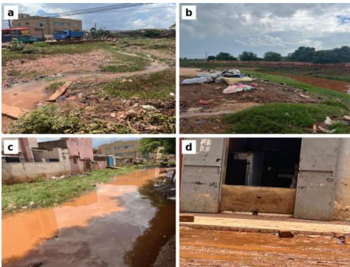
Figure 4 : (a) collecteur obstrué par les ordures et le sable ; (b) déchets sur la berge du marigot ; (c) eaux stagnantes dans une rue après la pluie du 4 août 2026 ; (d) muret provisoire devant une boutique Source : clichés personnels, Missabougou, 2026.
